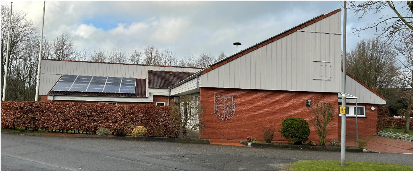
Abbildung 7: Gemeindezentrum mit integriertem Feuerwehrgerätehaus in West-Bargum
